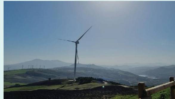
SERRALONGA ENERGIA S.R.L.
